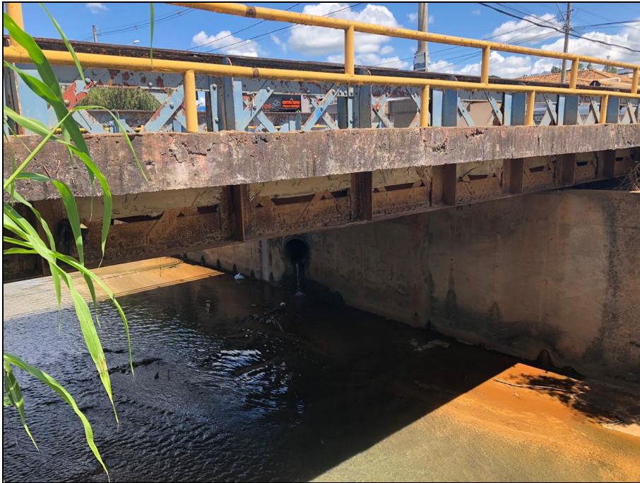
Foto 2 - Ponte existente - vista de jusante
