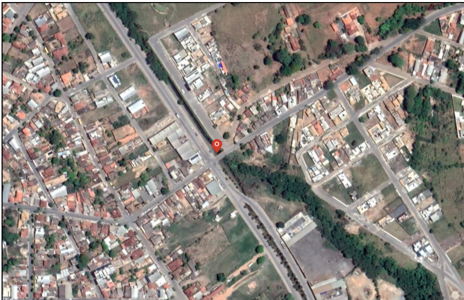
Foto 1 - Localização da Ponte
