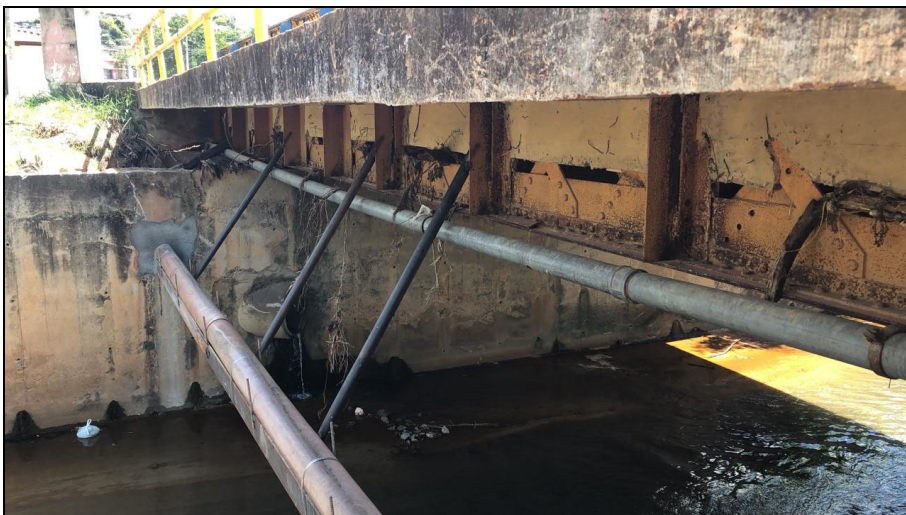
Foto 3 - Ponte existente - vista de montante
